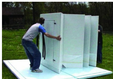
Figura 79 - Processo de montagem da habitação. Fonte: www.gvshelters.com . Maio, 2011.
