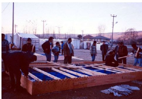
Figura 69 - Processo de montagem da habitação de papelão. Fonte: ANDERS, Gustavo Caminati. Abrigos Temporários de Caráter Emergencial. São Paulo, 2007. Maio, 2011.
