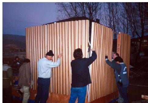
Figura 69 - Processo de montagem da habitação de papelão. Fonte: ANDERS, Gustavo Caminati. Abrigos Temporários de Caráter Emergencial. São Paulo, 2007. Maio, 2011.
