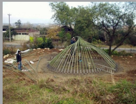
Figura 73 - Processo de montagem da estrutura do abrigo de bambu. Fonte: www.ciclovivo.com.br Maio, 2011.
